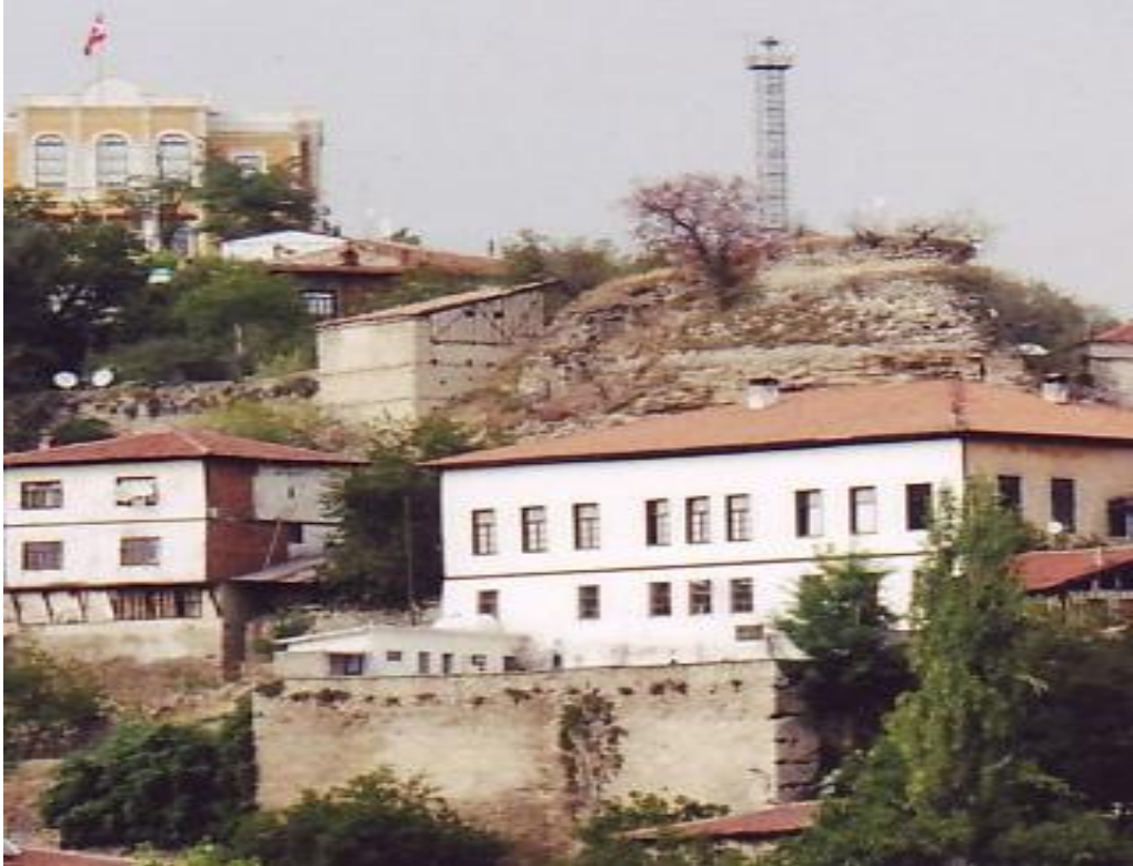
Burunsandal Kayası ile altında Kalealti İlkokulu ve okulun yüzlerce yıldır ayakta duran, yüksekliği ile ünlü bahçe duvarı; en üstte Kale'deki eski Hükümet Konağı
