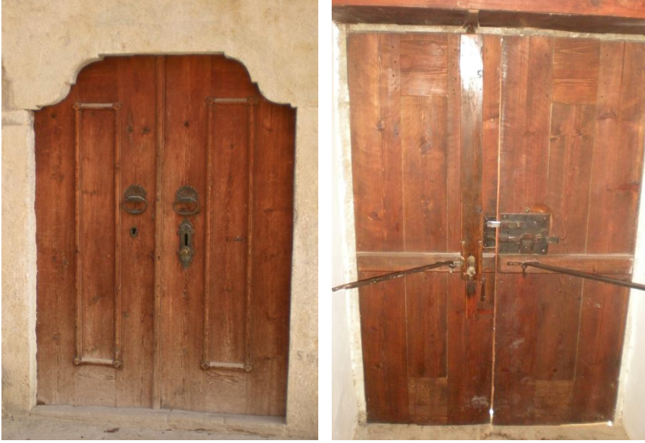
Hacıhüseyinler Evi'nin giriş kapısının sokak cephesi ve içerdeki kilidi ile demir dayakları
