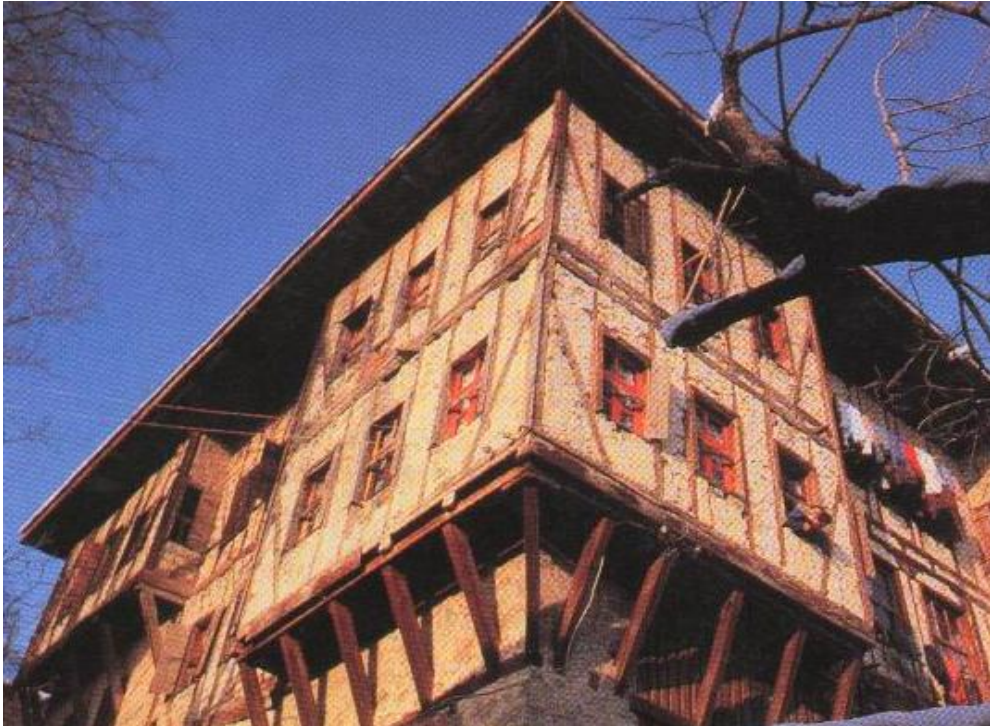
Akçasu'da Emeksizler Evi'nin yeydana'lardaki çatmaları, çıkmaları, geniş saçakları ve pencereleri (Bu görkemli evin 25 Eylül 2016 gecesi yanması, Safranbolu için çok acı ve üzücü, büyük bir kayıptır)
