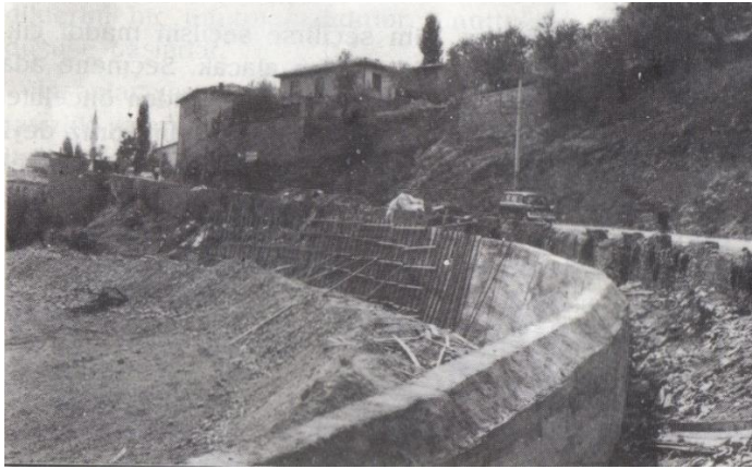
Hastahane altında, beton istinat duvarları yapılarak yol genişletiliyor-Temmuz/1975
