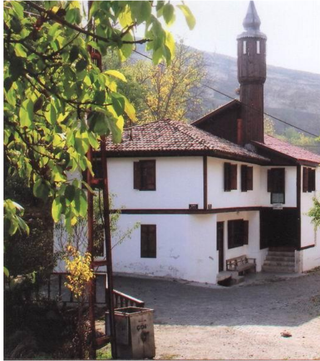
C- D- Akçasu'da Kaçak (Lütfiye) Camisi ve sol altta mahalle kahvesi
